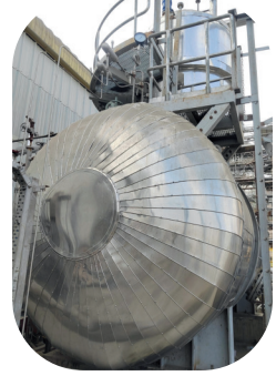
عزل وتغليف الخزانات الحرارية باحتراف عالي
