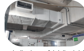
الدكتات الداخلية وموزعات الهواء
