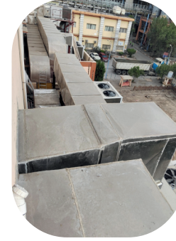
تصنيع وربط الدكتات الخارجية مع دوافع الهواء
